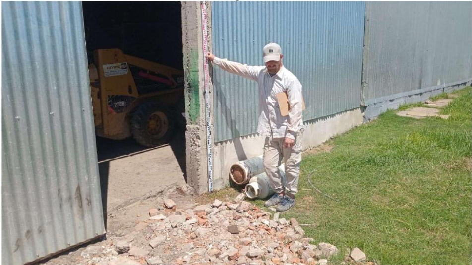
Foto 4: Punto Fijo. Cota +20.00 s/Riel portón del galpón.
